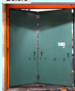
↑ 2つの部屋を温度を変えて運用するため、断熱扉に変更
